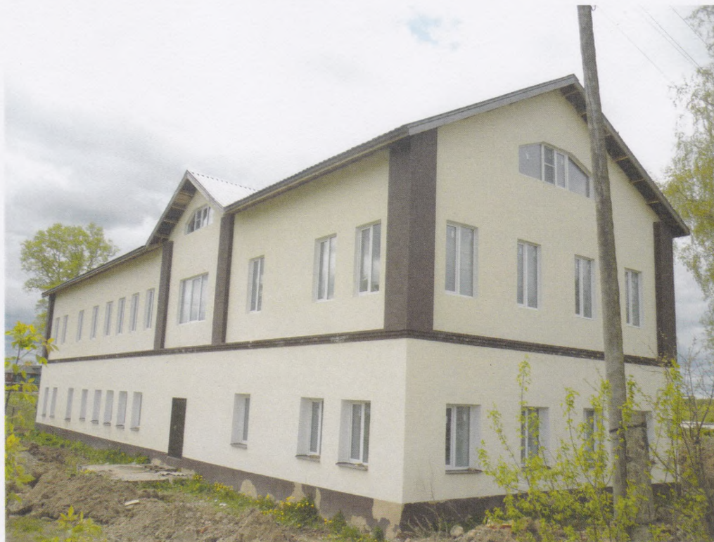
1. Флигель усадьбы Филатьевых. Вид с северо-востока
